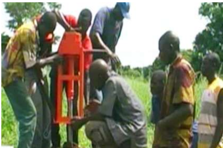
Remplacement d'une pompe par les artisans réparateurs de L'ONG
